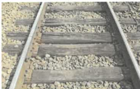
Rails courts sur traverses bois
